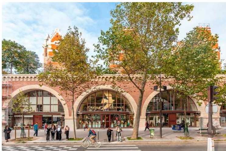
<Figure 12> Vue principale sur le Viaduc réhabilité
