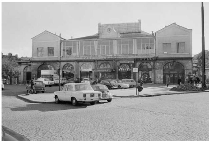
<Figure 4> Bâtiment voyageur de la gare de la Bastille durant les années 1960
