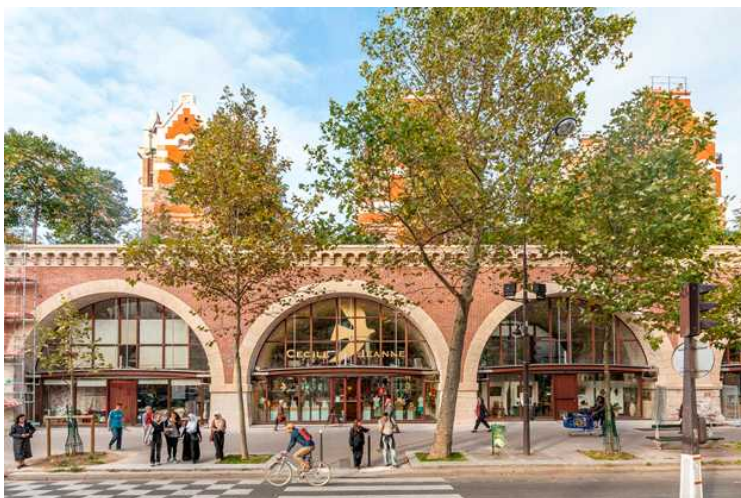
<Figure 12> Vue principale sur le Viaduc réhabilité
