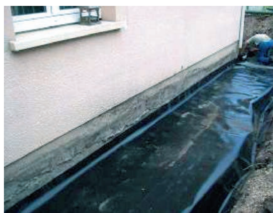
Figure 22 Géomembrane en cours de pose (Source Socabat)
