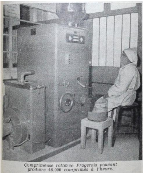
Comprimeuse rotative Frogerais pouvant produire 48.000 comprimés à l'heure.
