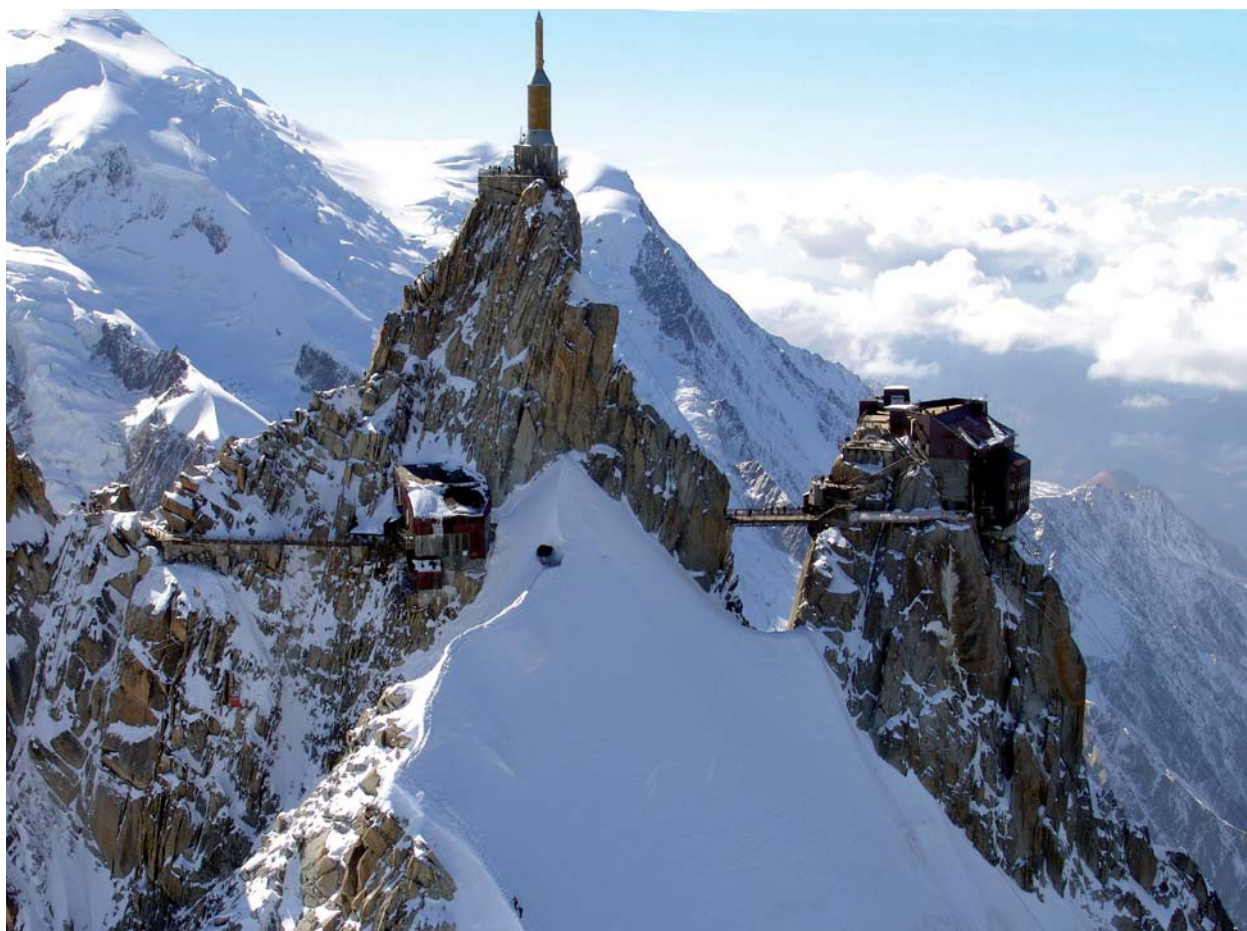
Figure 2 - L'Aiguille du Midi (3842 m) vue depuis l'est. L'un des forages pour le suivi de la température de la roche est situé en contrebas de la passerelle de gauche (photo S. Gruber).
