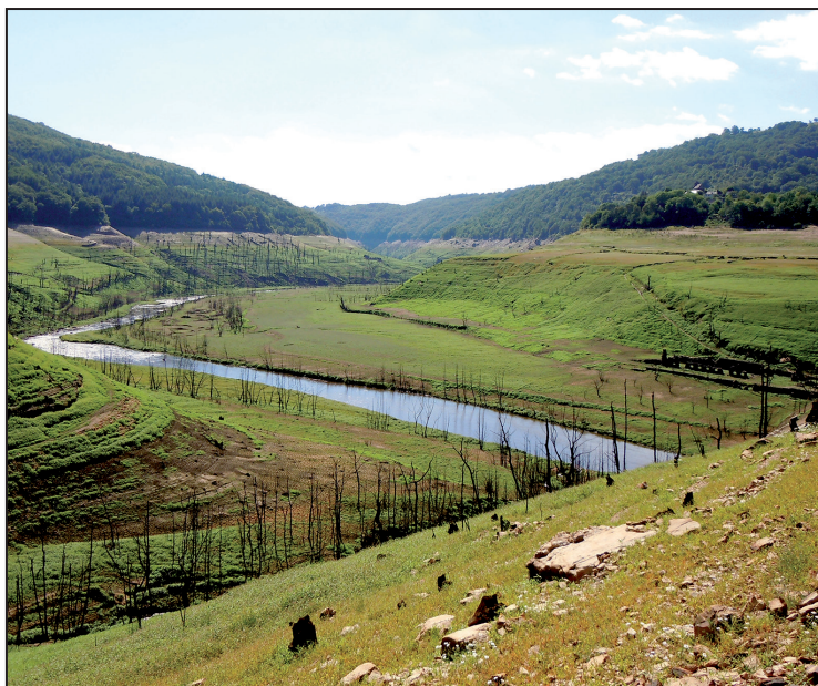
Figure 1 - Vue générale du réservoir de Sarrans lors de la vidange de 2014. Figure 1 - General view of the empty reservoir of Sarrans in 2014.
