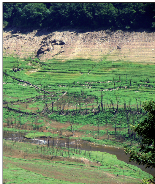
Figure 2 - Détail du réservoir de Sarrans lors de la vidange de 2014. Vue de la zone de marnage fréquent en haut, jusqu'à la zone toujours en eau en bas. Figure 2 - Detailed view of the slope of the reservoir in 2014. Top: annual drawdown zone. Bottom: permanently flooded zone.
