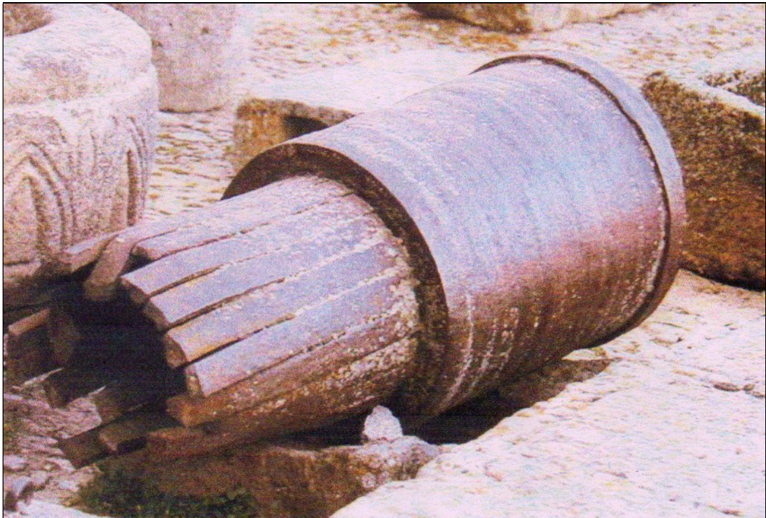
Figure 7 – Fragment de bombarde à Pinhel (Portugal) montrant l'assemblage des douves longitudinales (Lopez Martin, 2011)
