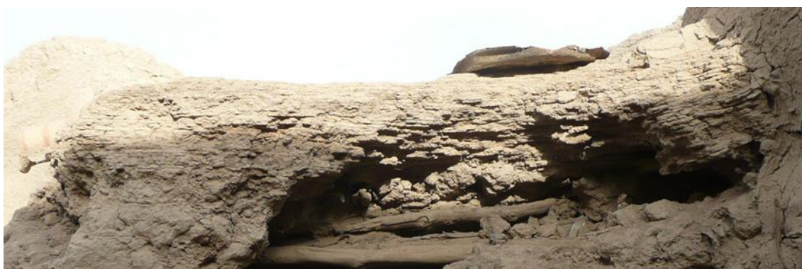
Fig.2 – Las capas de enlucidos cambian la forma, Ciudad de Dia, Mali.
