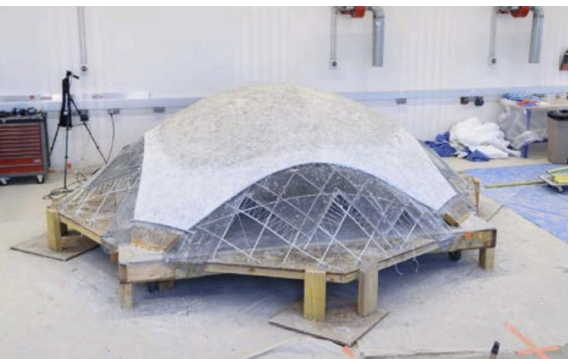
(e) Projection du béton
