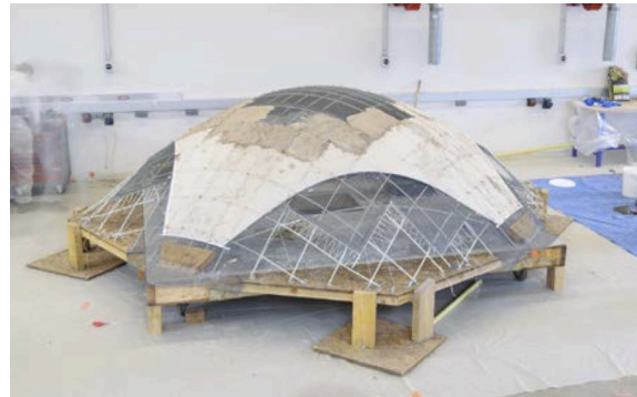
(d) Pose d'une primaire d'accroche au ciment prompt
