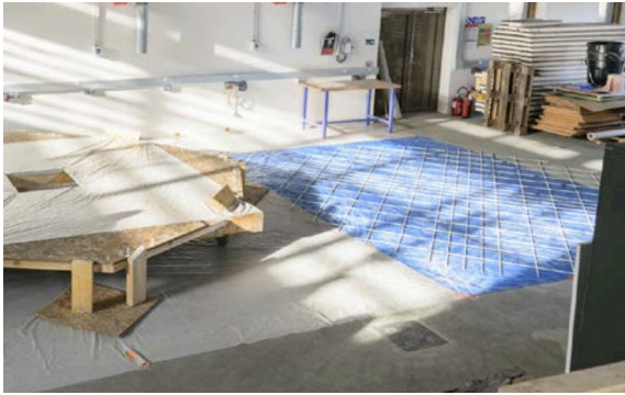
(a) Assemblage de la grille
