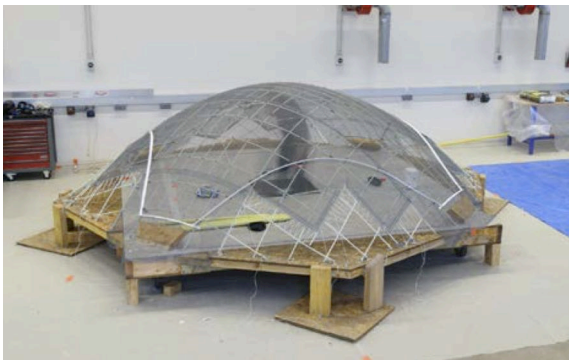
(c) Mis en forme du gridshell
