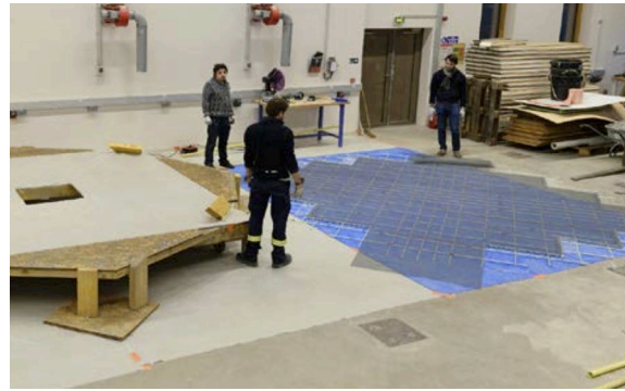
(b) Pose de la toile de coffrage
