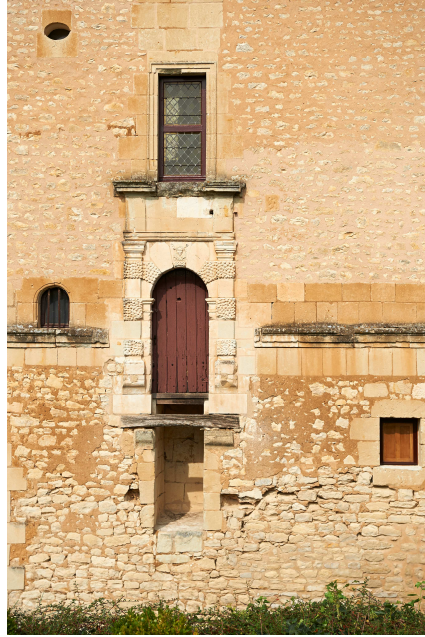
Figure 3 : emplacement du pont-levis de La Grande-Jaille (côté parc)
