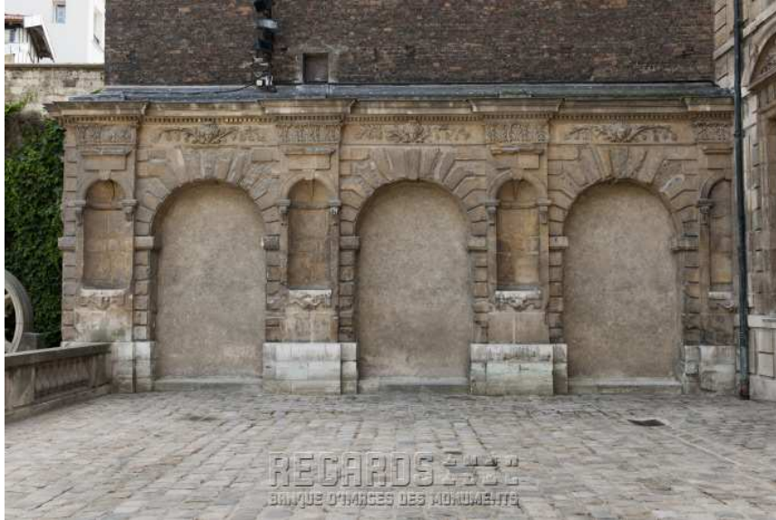
Figure 7 : mur renard de l'hôtel de Sully
