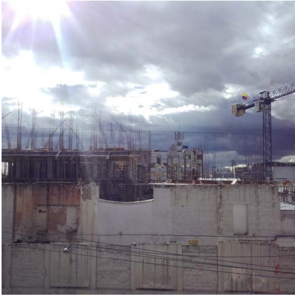
En chantier, Bogotá 14 juin 2017
