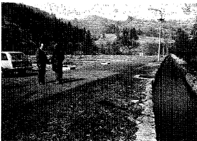
Photo 6 : Pisciculture de Bechov. Unité de grossissement avec recyclage partiel. A droite, canal d'alimentation avec, au-dessus, la canalisation qui ramène une partie de l'eau en amont du canal.
