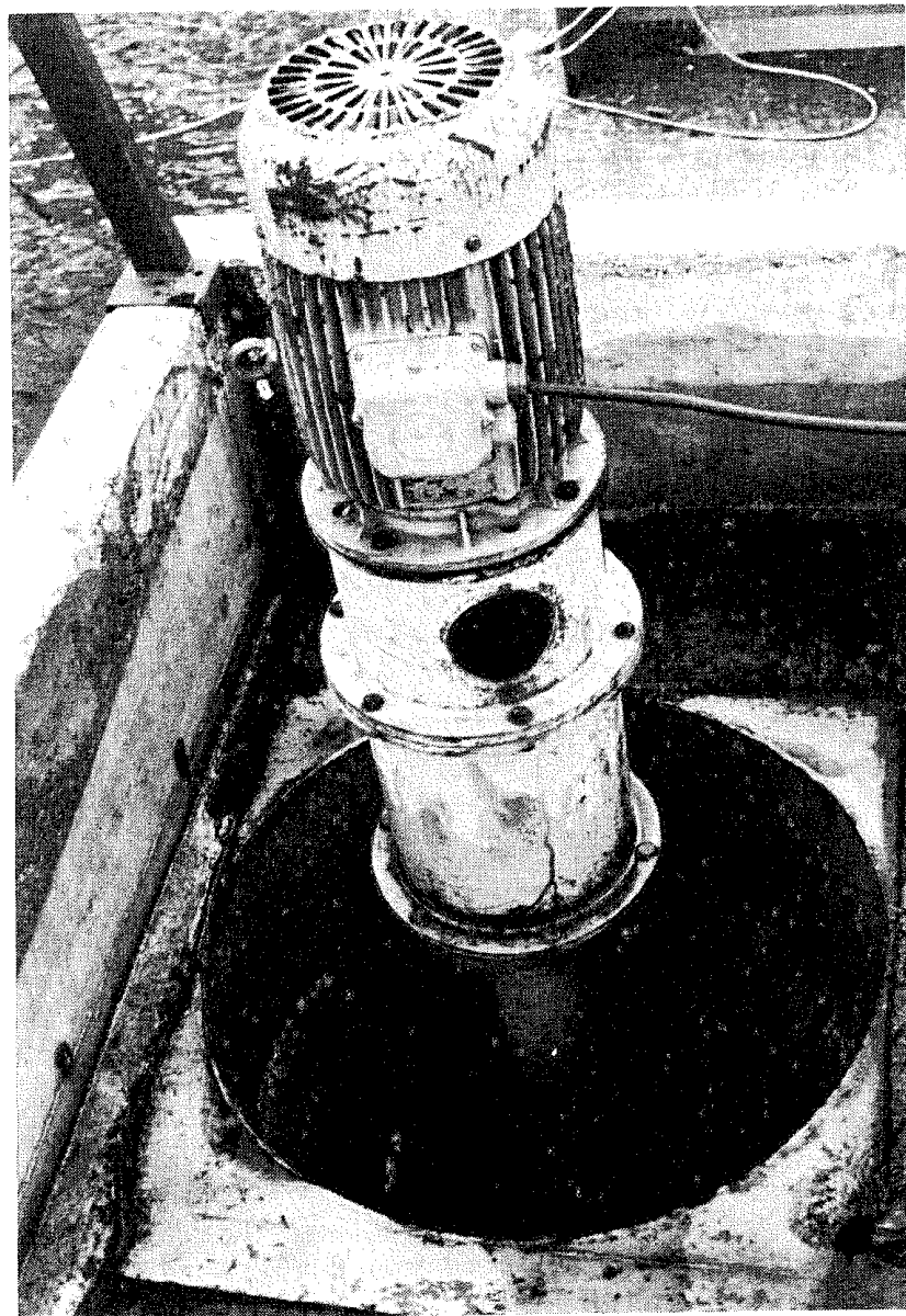
Photo 8 : Elévation d'eau par pompe à hélice. L'arrivée d'eau est dans l'axe de l'arbre de pompe (perte de charge minimale) Pisciculture bretonne (Le Dreff)
