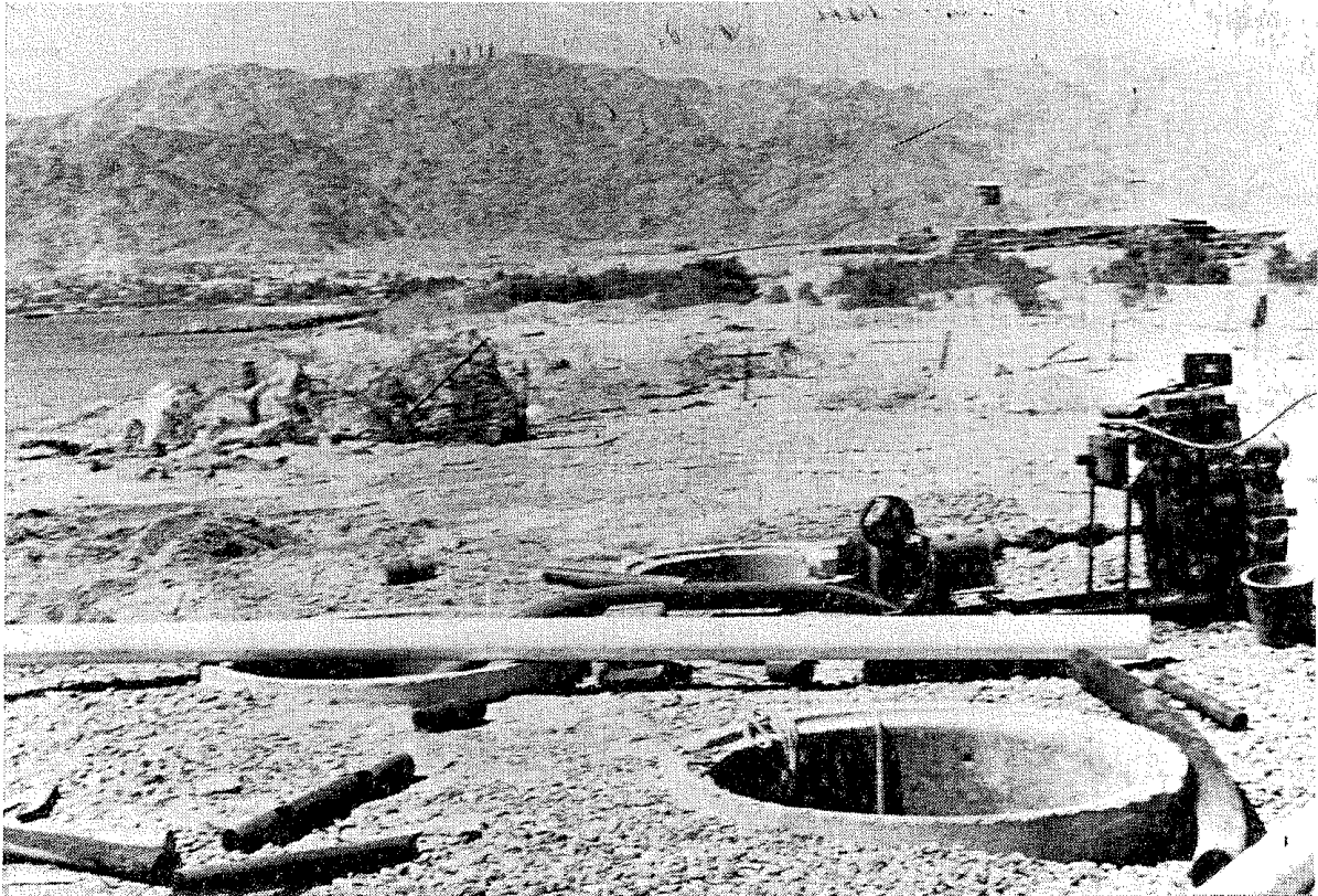
Photo 9 : Prise d'eau de mer par pompage à proximité du littoral dans des puits (filtration) Aquaculture (Eilat-Israël)
