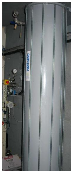
**Figure 68** - Système de purification PSA (Verdemobil)
