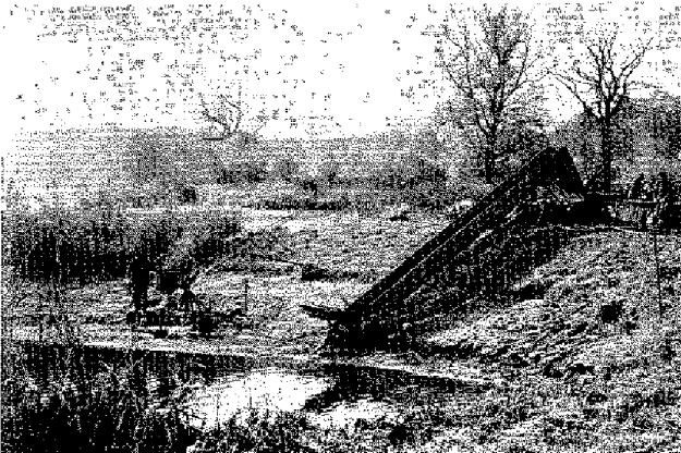
Photo 30. — Dispositif de capture et de transfert des poissons sur le chantier de tri.
