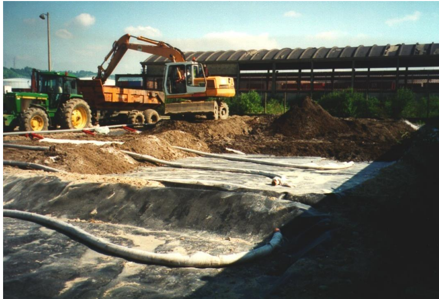
En cours de réalisation
