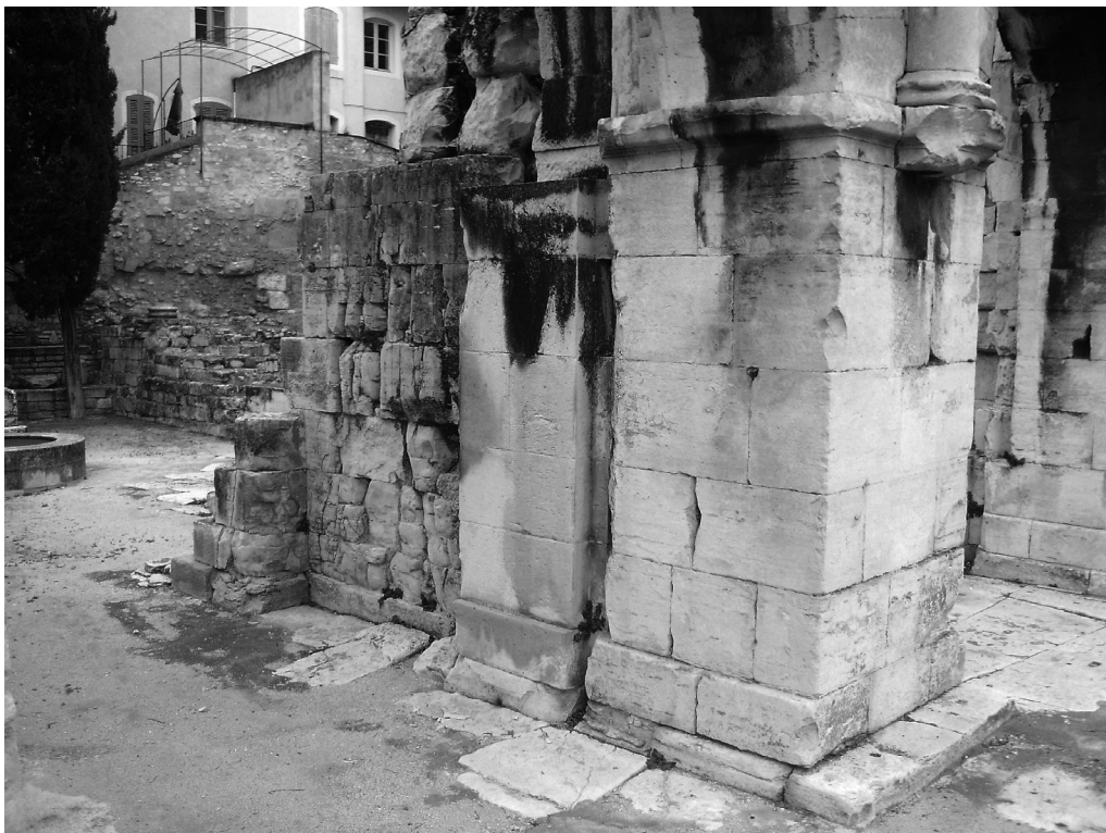
Fig. 6. La porta Praetoria (Aoste). Vue depuis l'intérieur de la cour : au fond, la paroi latérale de la tour de flanquement nord ; à droite, la face arrière du corps de la porte côté ville ; à gauche, la face arrière du corps de la porte côté campagne.
