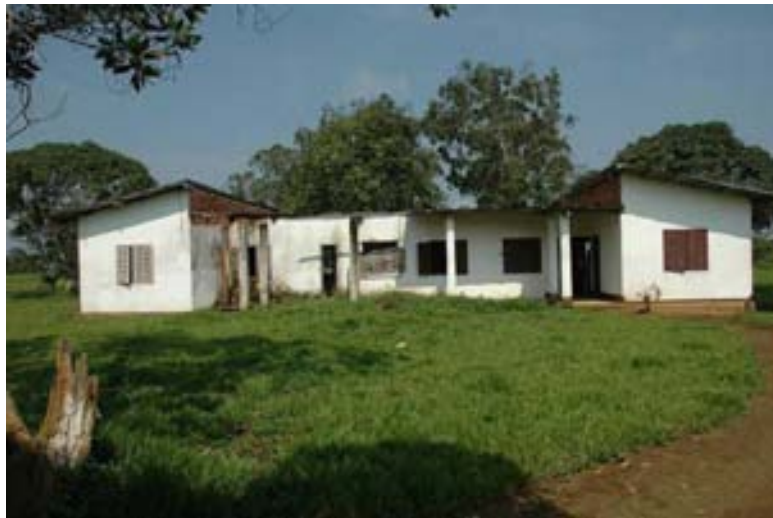
Photo 11 : Une partie des bureaux de la Préfecture de Kingoué n'a jamais été réhabilitée
