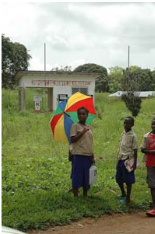
Photo 8 : Station service inutilisée à Kingoué
