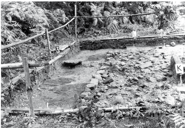
K11 - Façade Est du pavage, avant et après les travaux : ou quelques pavés ont été remplacés dans l'alignement.
