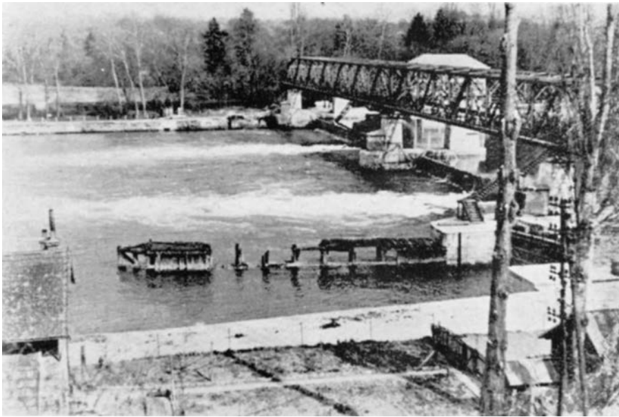
Fig. 19. Veines convergentes à l'aval du Barrage de Vives-Eaux sur la Seine [14].
