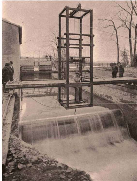
Fig. 3. Le canal courbe du laboratoire de Baniève, et nacelle de mesure du débit à l'aide du déversoir de Bazin (Arch. IMFT).
