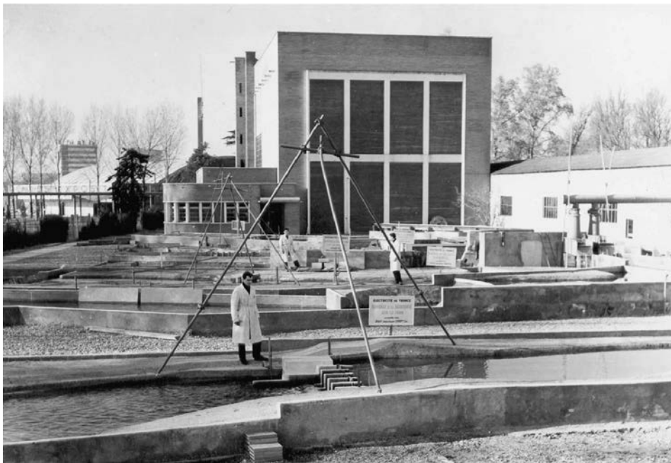
Fig. 7. Le «laboratoire plat» des modèles réduits, sur un terrain acquis en 1943, face au bâtiment de la soufflerie (archives IMFT). Cet espace sera couvert en 1962.
