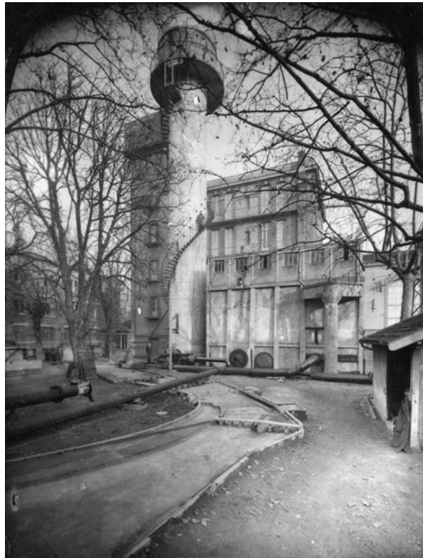
Fig. 2. Dans la cour de l'IET, modèle réduit de la Garonne et du Pont-Neuf à Toulouse (Arch. IMFT). Les modèles réduits seront progressivement transférés sur le site de Banlève à partir de 1920.
