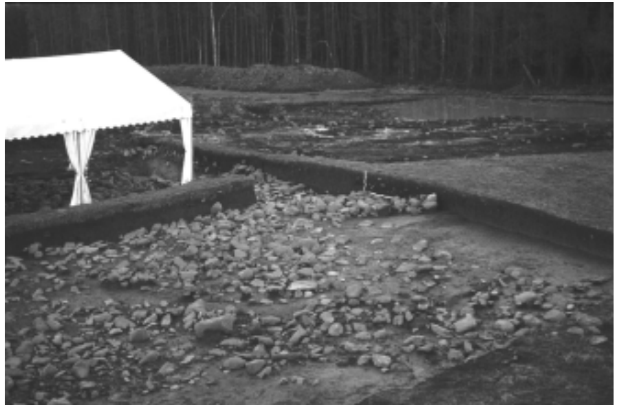
Fig. 10 : Le premier décapage du socle sud-ouest, vu du sud-ouest. Photo : Y. Tchérémissinoff (Inrap).
