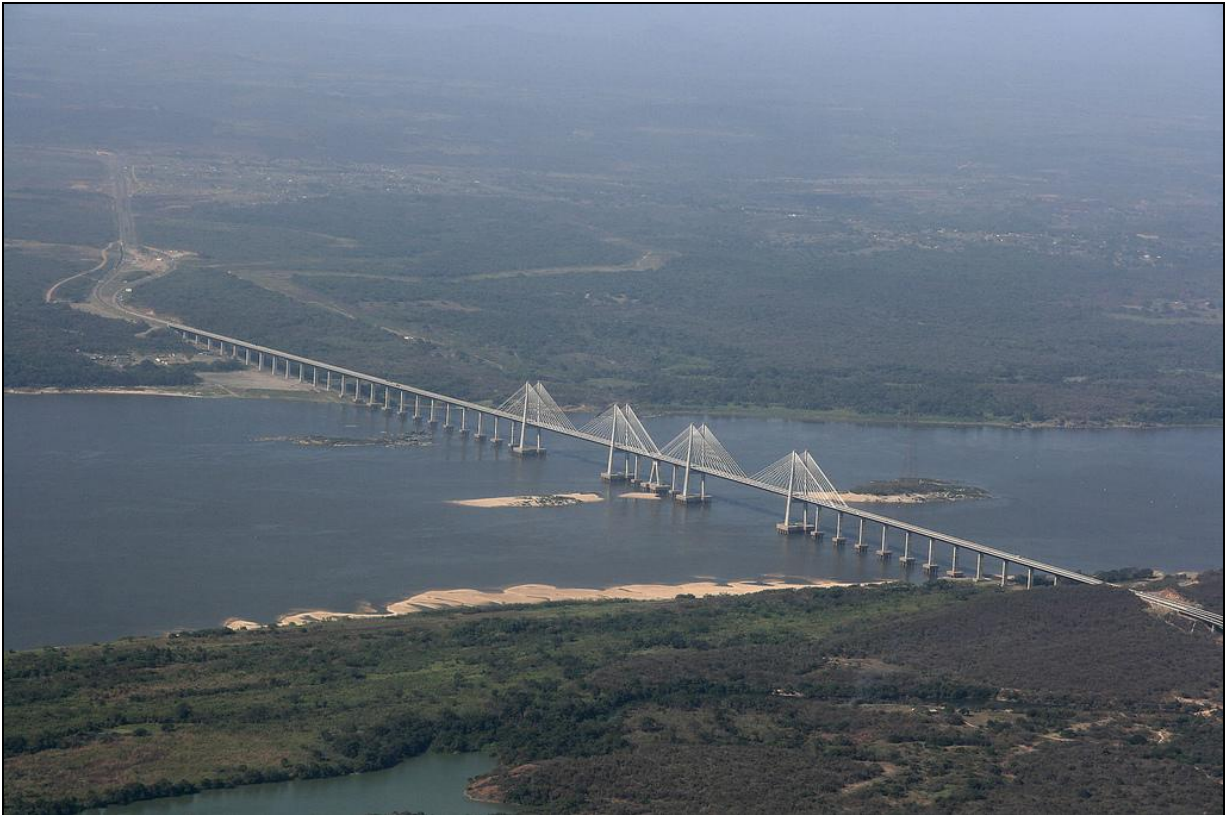
Photographie n 15 : Le pont Orinoquia , vue aérienne depuis la rive gauche.
