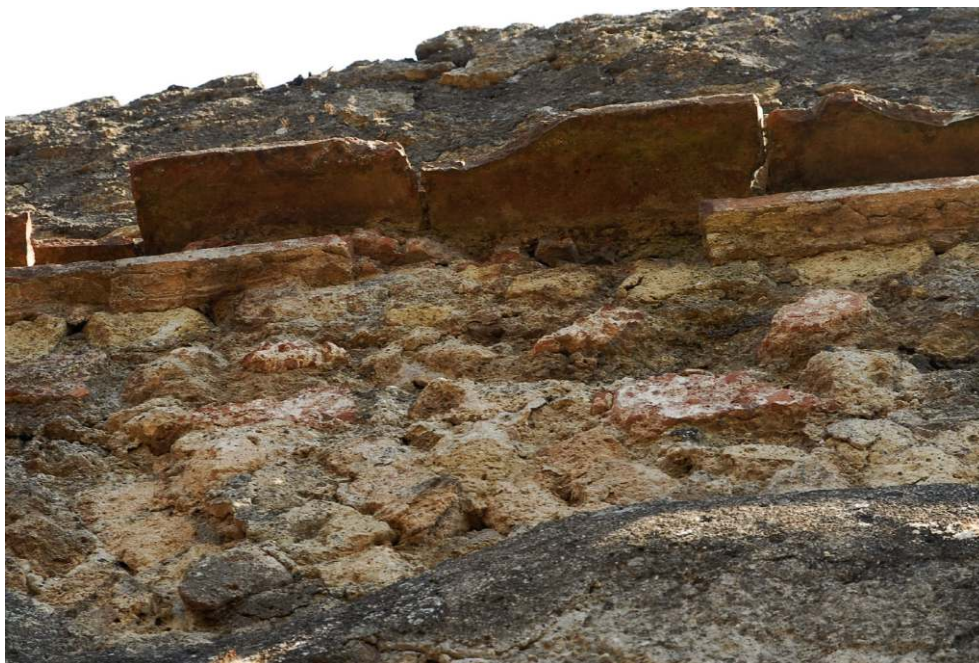
Fig. 10 – Portique sud du RDJ (63), portion ouest (entre les piliers 383-387 et 389 et 390).
