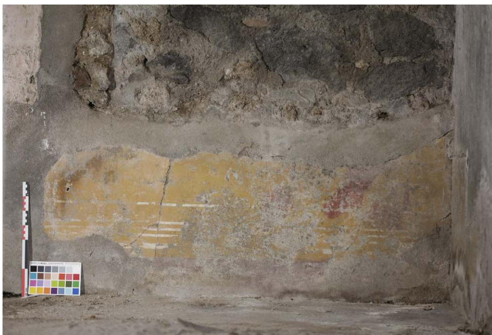
Fig 8 – Pièce 13, mur sud, parement nord (2) : restes de l'enduit de première phase.
