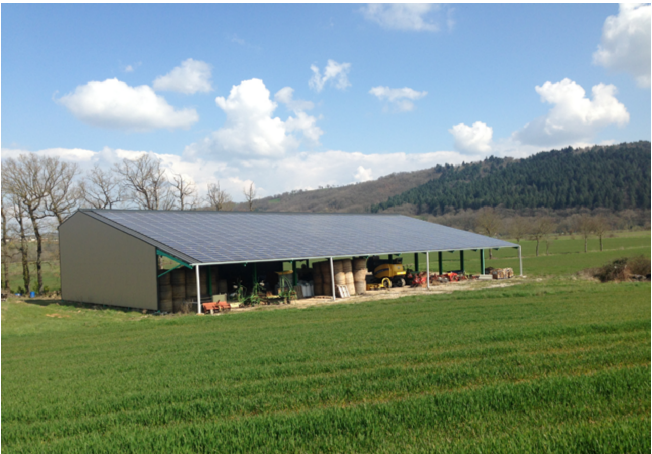
Toiture photovoltaïque sur un hangar agricole © Fermes de Figeac
