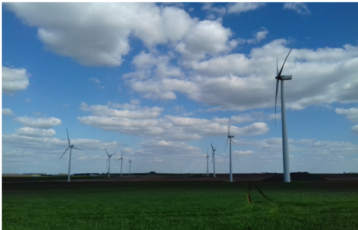
Parc éolien du ROCHEREAU II © Sergies
