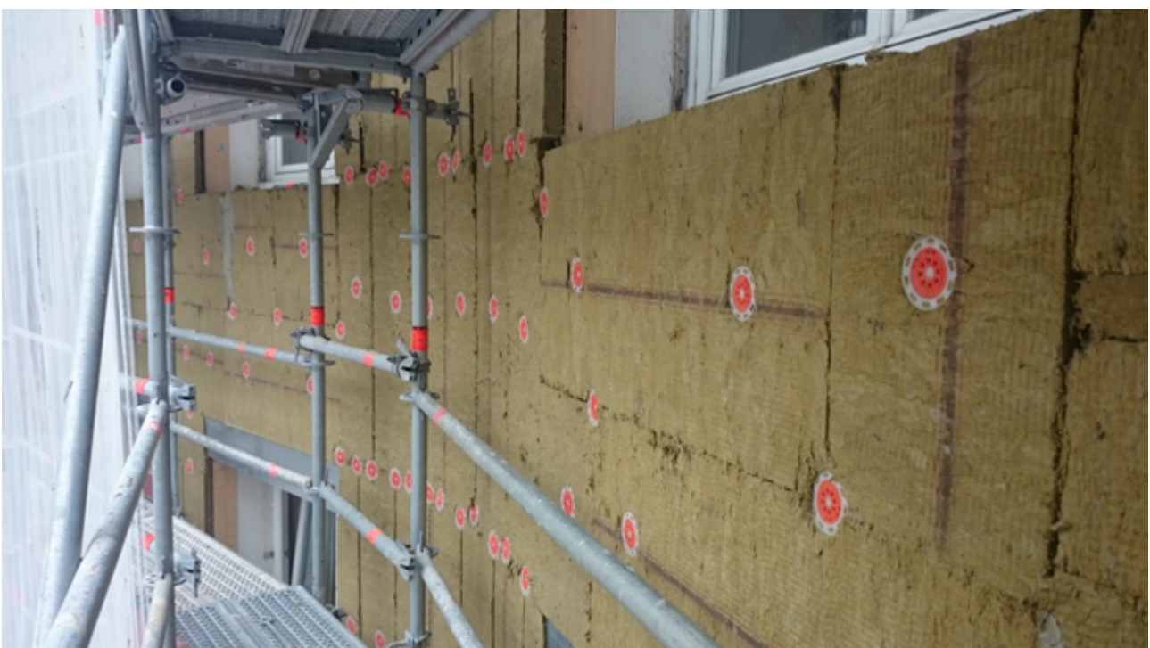
Isolation de la copropriété Lançon-Rungis © Energies POSIT'IF
