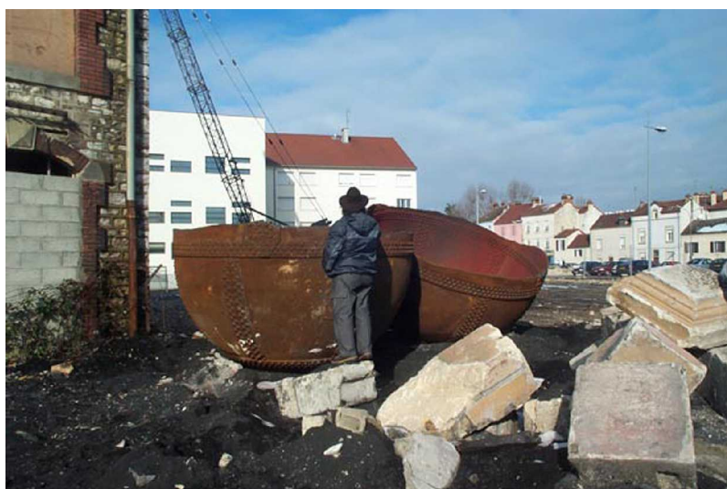
Les deux fonds de cuve, sur le site de la sucrierie
