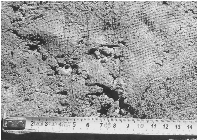
FIGURE 10. TRANCHEE T5. INTERFACE SOL/GEOTEXTILE VUE DEPUIS L' AVAL.
