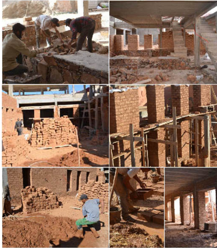
Figure 19 : Work in progress, le bâtiments en cours de construction : pierres de soubassements sur structure partielle en béton armé, adobes pour les parois pour une épaisseur permettant une bonne isolation thermique (60 à 80 cm), Salima Naji ©.
