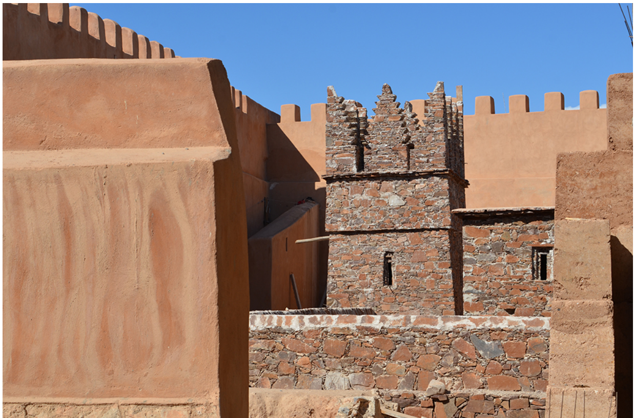
Figure 18 : Vue extérieure du bâtiment dans les remparts de la Kasbah Aghenaj, le grenier en pierre de Wijane est en cours de construction à l'échelle 1 dans les espaces musographiques, tandis que sont édifiés les murs de pisé sur une structure en Béton armé imposée par la législation. Photos en haut, Mehdi Bensid ©, en bas, Aissam Haddioui ©.
