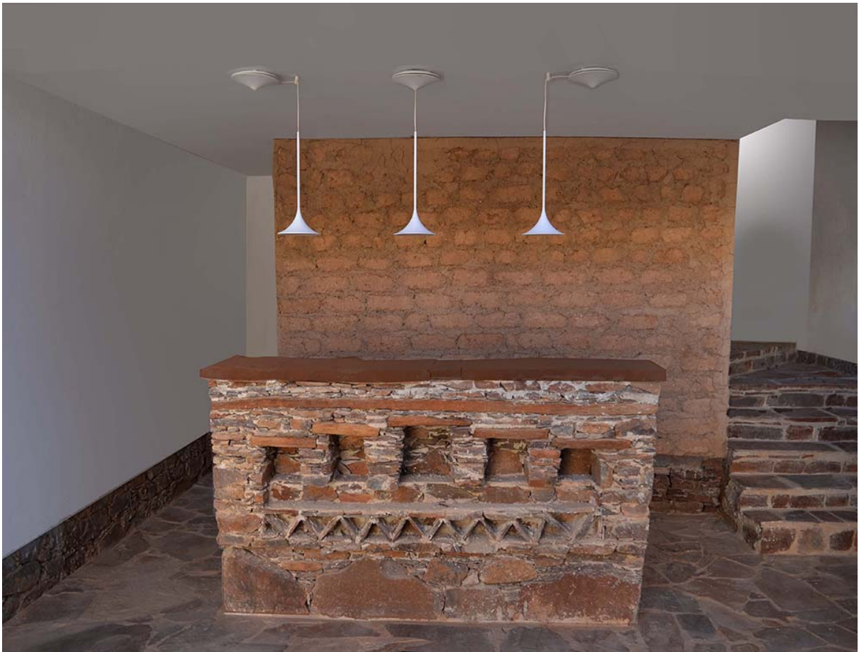
Figure 21 : Vue intérieure du bâtiment du centre des archives. La pierre et la terre sont partiellement laissées apparentes pour faire manifeste et montrer l'importance des mises en oeuvre vernaculaires. Salima Naji ©.
