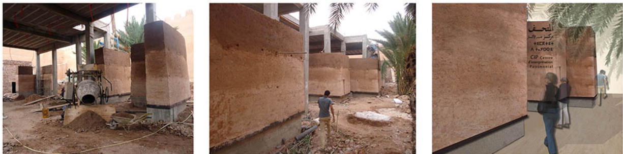
Figure 16 : Vue extérieure du bâtiment Le socle en béton présente un léger porte-à-faux pour mieux mettre en valeur le pisé dans les vues extérieures du bâtiment et souligner ainsi son emploi. Le mur de pisé présente un parement pyramidal calculé en fonction des hauteurs finales du bâtiment (de 5 à 8,5 m.)
