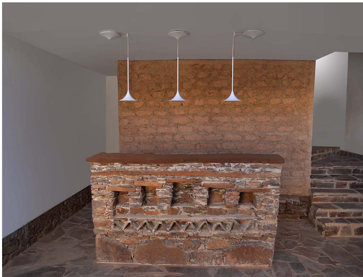
Figure 21 : Vue intérieure du bâtiment du centre des archives. La pierre et la terre sont partiellement laissées apparentes pour faire manifeste et montrer l'importance des mises en oeuvre vernaculaires. Salima Naji ©.
