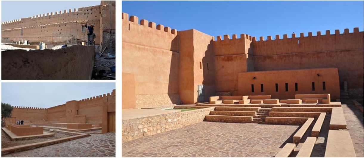
Figure 10 : Le théâtre de plein-air de la Kasbah Aghenaj, avant et après la réhabilitation des remparts (2008-2009), Agence Salima Naji ©. Le programme prévoyait au départ un auditorium sans en avoir le budget. Un théâtre de plein-air a été modelé dans la partie Nord de la Kasbah, le reste du lieu étant consacré aux espaces muséaux.
