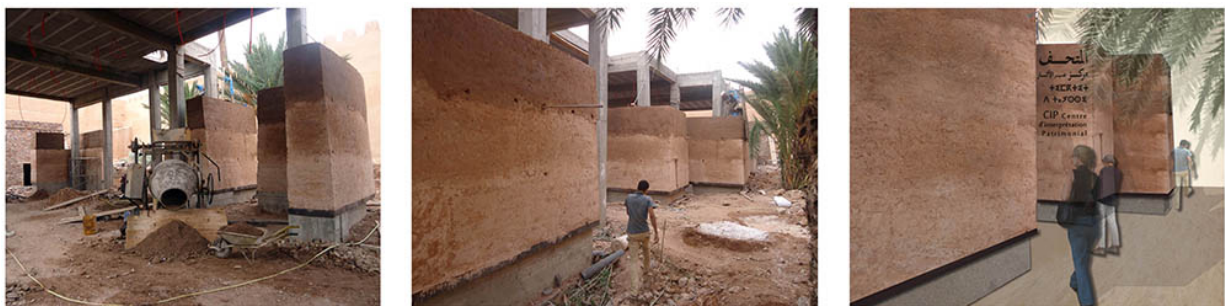
Figure 16 : Vue extérieure du bâtiment Le socle en béton présente un léger porte-à-faux pour mieux mettre en valeur le pisé dans les vues extérieures du bâtiment et souligner ainsi son emploi. Le mur de pisé présente un parement pyramidal calculé en fonction des hauteurs finales du bâtiment (de 5 à 8,5 m.)
