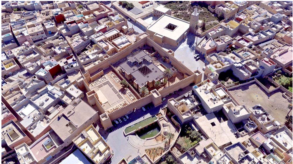
Figure 11: Vue zénithale du Premier Secteur Sauvegardé : les mises en valeur des différents sites tendent à se matérialiser, les chantiers se cloturent les uns après les autres. Photographie par drone de Mehdi Bensid 2016 ©.
