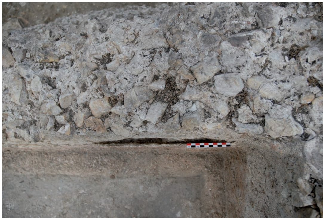
Fig. 16. Vue des différents revêtements (mortiers et bourrelets d'étanchéité) (cl. Br. Ephrem).
