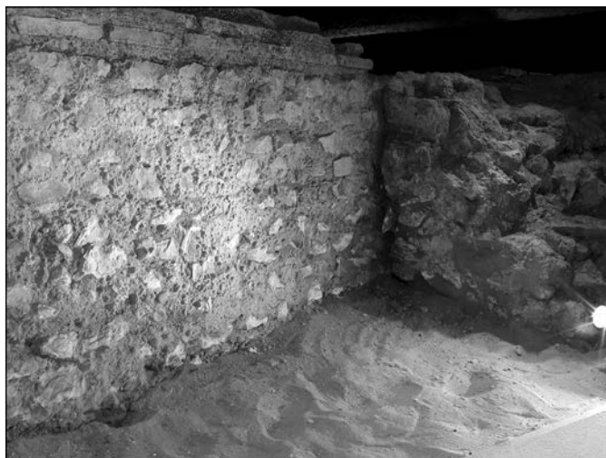
Fig. 5 – Vue d'un des contreforts occidentaux venant s'appuyer contre la façade ouest du bâtiment public (cliché : A. Bouet, Université Toulouse-II).
