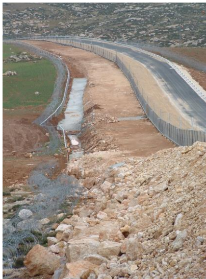
Photo 1. Portion de la barrière de séparation en construction, Sud de Samu' (Cisjordanie 2006). Cliché : Cédric Parizot
