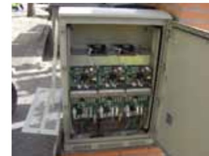
Málaga. Éclairage public sur le Quai Maritime de l'est, doté d'un système de télégestion et de réducteurs-stabilisateurs de flux lumineux
