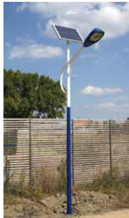
Toulouse. Lampadaires avec des panneaux photovoltaïques dans l'espace public de Borderouge
