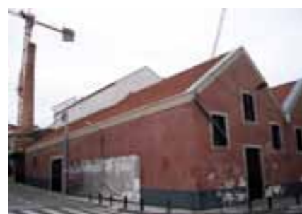
Vila Nova de Gaia. Exemple de réhabilitation et conversion de bâtiments désaffectés en équipements : Centre multimédia «Vinho do Porto» et «Cais Cultural»
