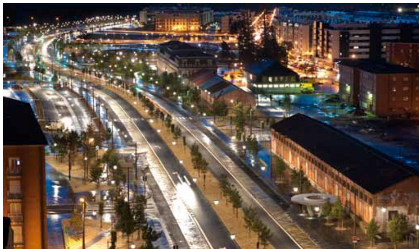
Burgos, l'éclairage du Boulevard ferroviaire avec un double niveau de régulation
