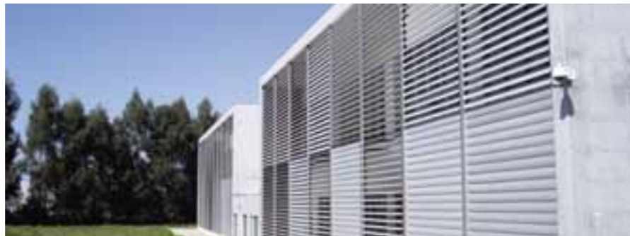
Vila Nova de Gaia, persiennes d'ombrage dans un immeuble de logements sociaux "Villa d'Este" (ci-dessus) et lamelles de stores réglables dans l'immeuble de services "Inova Gaia" (ci-dessous).
