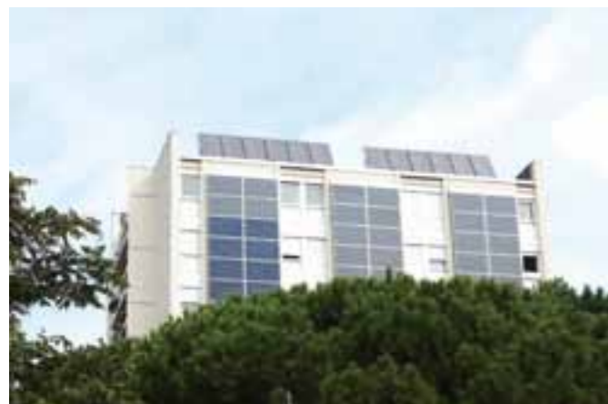
À gauche, Toulouse: Réhabilitation d'intérêt social, Opérateur Patrimoine. Isolement extérieur, installation de panneaux photovoltaïques et thermiques. À droite, Burgos: ARI Rio Vena, comme exemples de réhabilitation énergétique d'habitation
