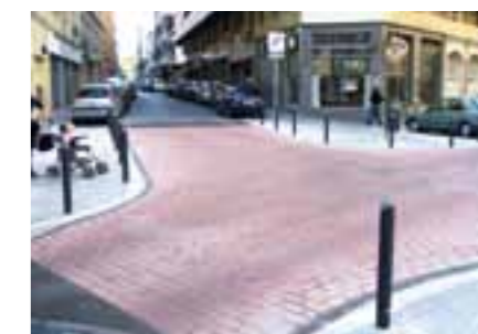
Málaga. Plan d'implantation de la limitation à 30 km/h et plateau pour réduire la vitesse en zone à 30 sur l'artère Heredia
