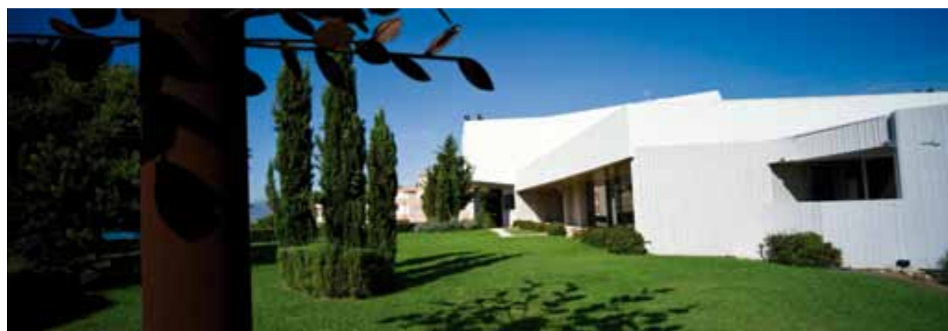
Málaga, Observatoire de l'Environnement Urbain. Bâtiment construit avec des techniques de construction écologiques (végétation et matériaux locaux, système de récupération des eaux de pluie, orientation nord-sud, panneaux solaires photovoltaïques...) pour réduire l'impact sur l'environnement
