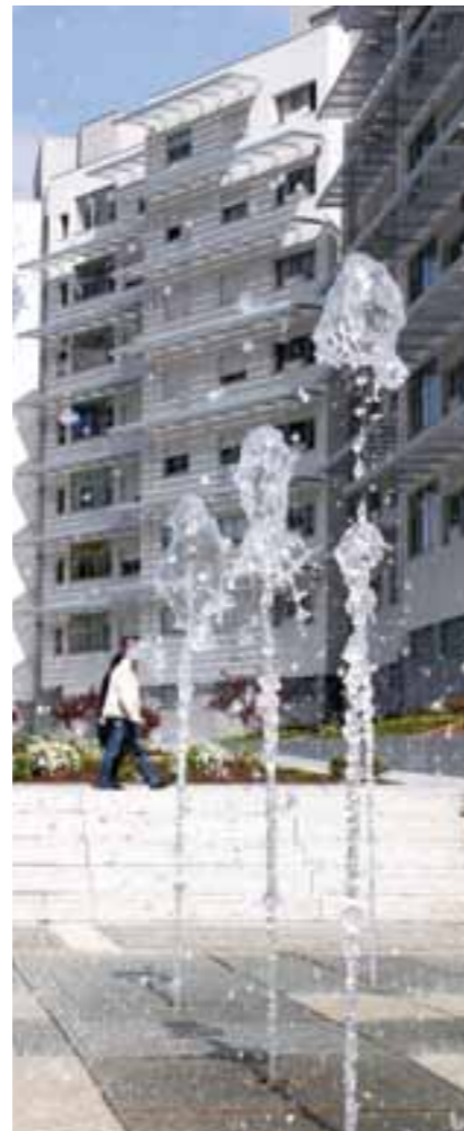
Vila Nova de Gaia, les bâtiments ont des besoins énergétiques compatibles avec la géothermie
