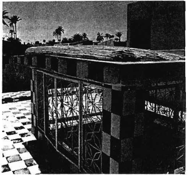
Terrasse et dispositif d'éclairage du wast ed-dar
