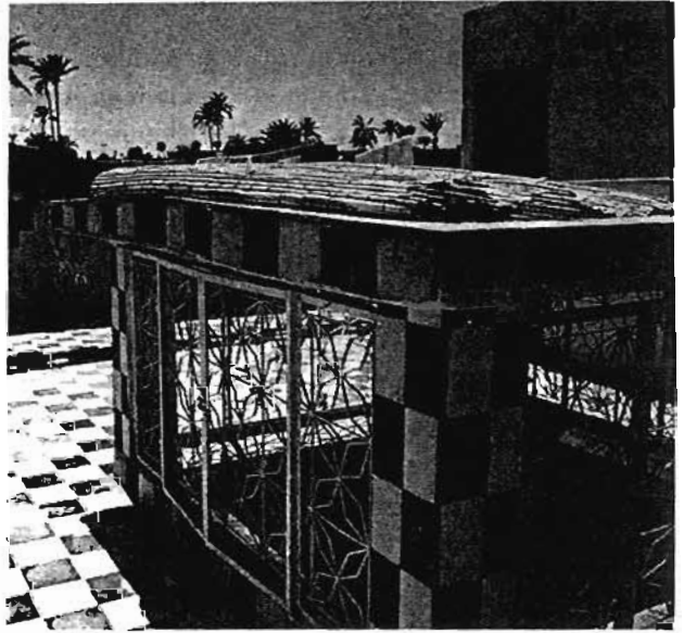
Terrasse et dispositif d'éclairage du wast ed-dar
