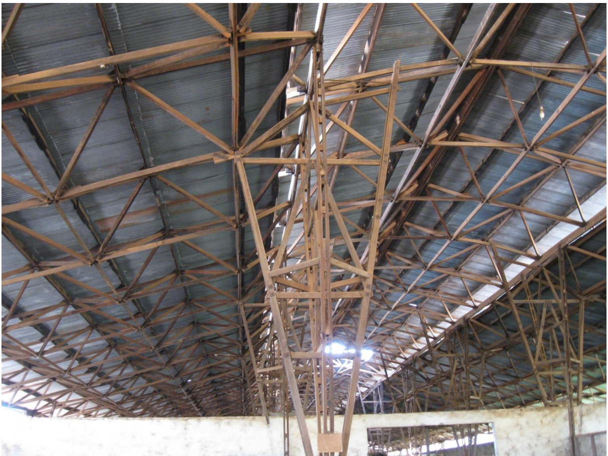
15- Vue générale de la charpente APLEX de Yaoundé, mai 2017 © G-A Langlois
