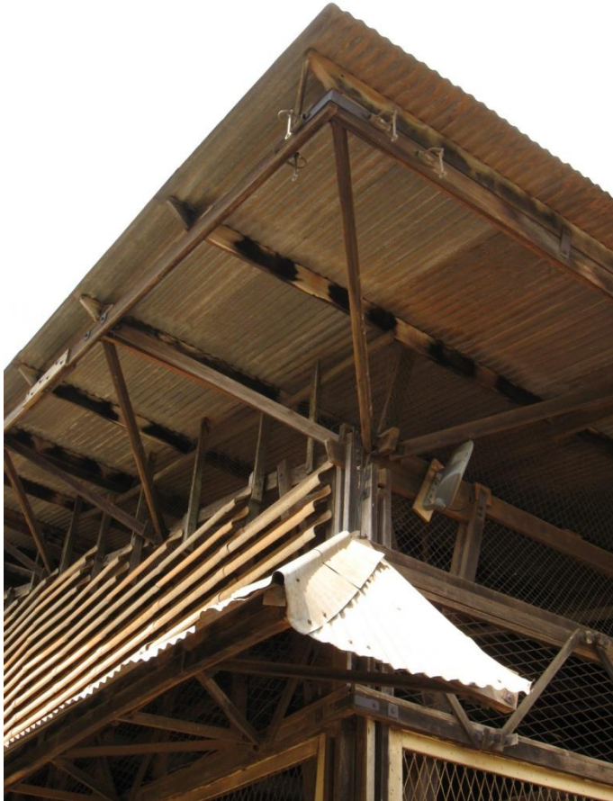
16- Angle du hangar et recouvrement des pignons, mai 2017 © G-A Langlois
