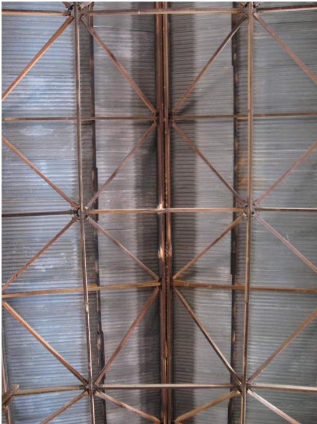
12- Charpente du lanterneau, mai 2017 © G-A Langlois
