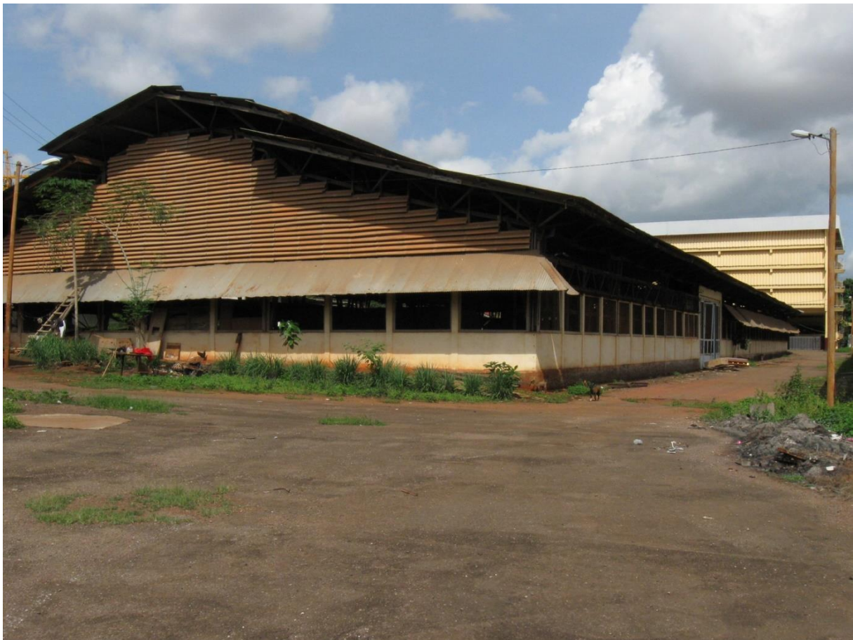
1- Vue générale du garage administratif de Yaoundé, mai 2017 © G-A Langlois
