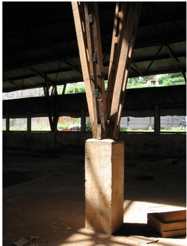
13- Piliers porteurs en béton, mai 2017 © G-A Langlois
