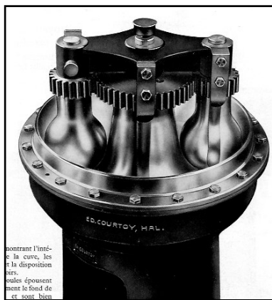
Broyeur à boulets satellites avec raclours Courtoy (1930)
