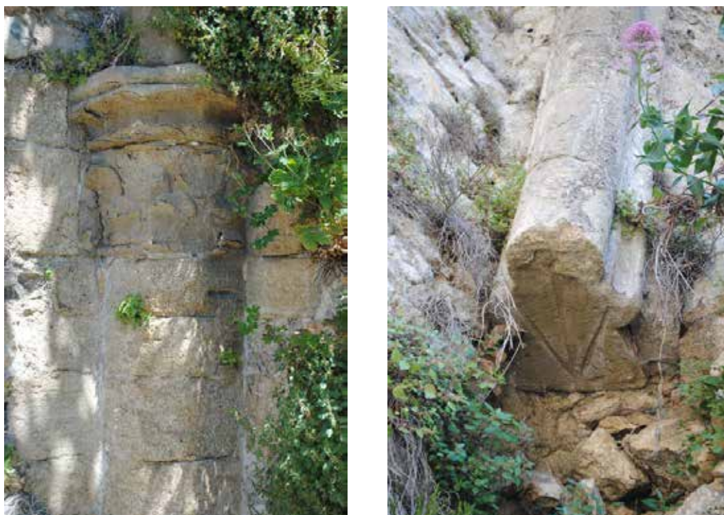
Fig. 11 et 12. Détail des matériaux et traces de mise en œuvre.
