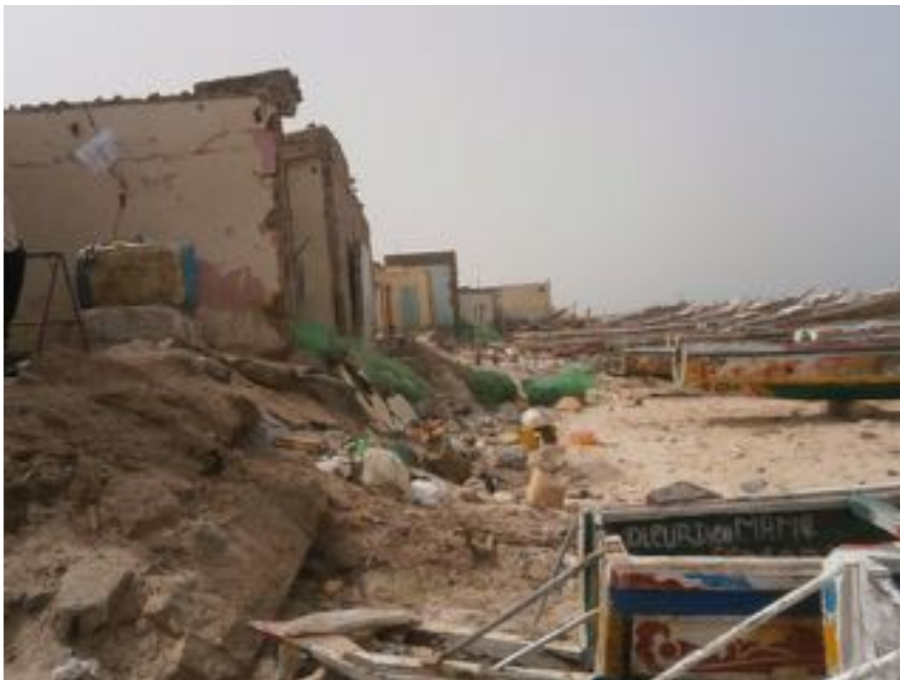
Figure 7. Maisons détruites par l'érosion côtière (Saint-Louis). Source : Photo C. Kane 2015
