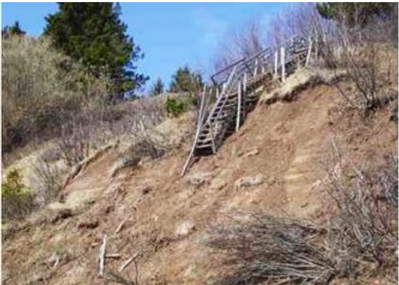
Figure 12. Effondrement d'un escalier d'accès à la plage à Carleton suite à l'érosion de la falaise. Source : Photo S. Weissenberger, 2012.
