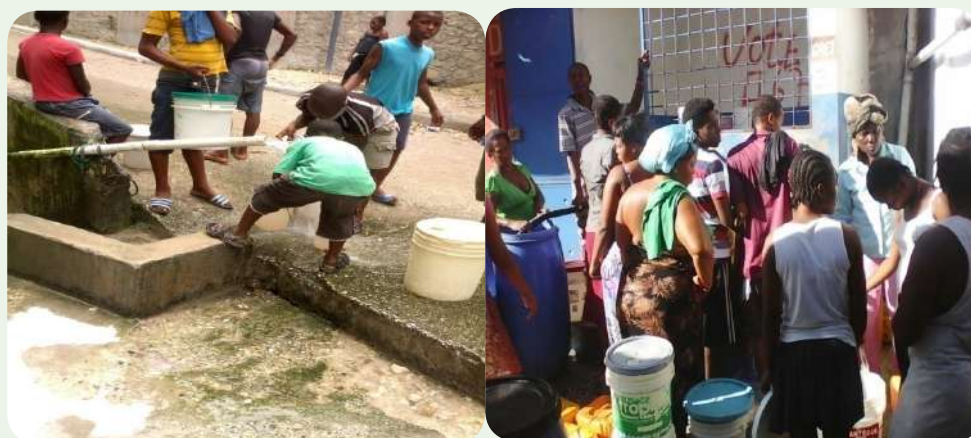
Figure 2: conduites visibles sectionnées (secteur public) : File d'attente devant un kiosque
