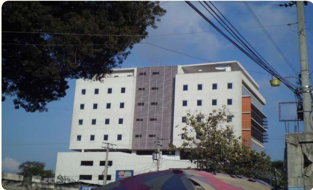
Photo 3 : Façade ouest du nouveau bâtiment logeant le Ministère de l'Intérieur et des Collectivités Territoriales (MICT) Rue Paul VI. (Crédit photo : Jean Odile ETIENNE, 2017)
