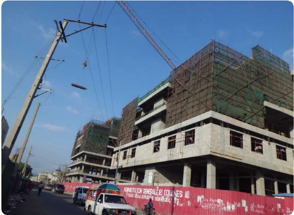
Photo 2 : Les locaux de la Direction Générale des Impôts et de l'Administration Générale des Douanes (en construction façade ouest de la rue de la Réunion). Crédit photo : Jean Odile Etienne, Février 2017)
