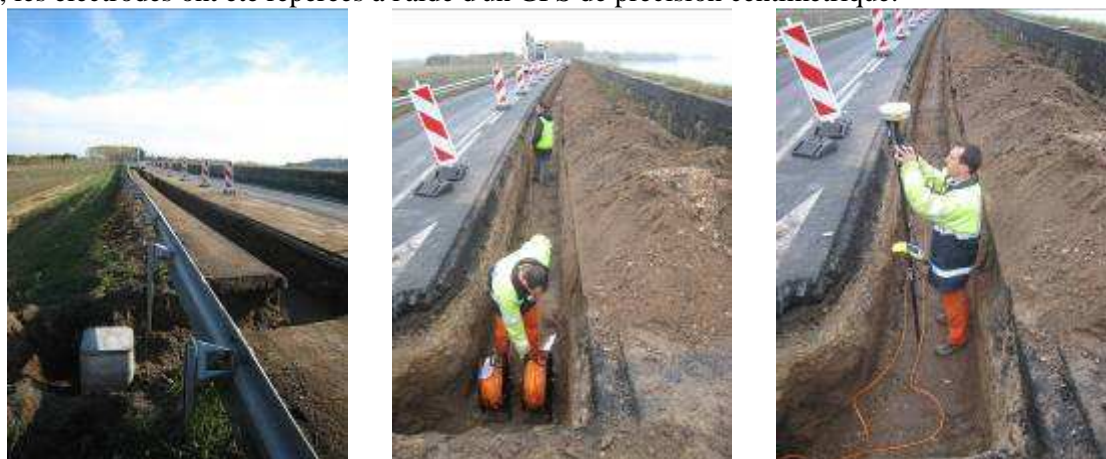
Figure 5 : Vues de l'installation des lignes d'électrodes sous la chaussée : tranchées côté val (à gauche), côté Loire (au centre) et repérage au GPS (à droite).
