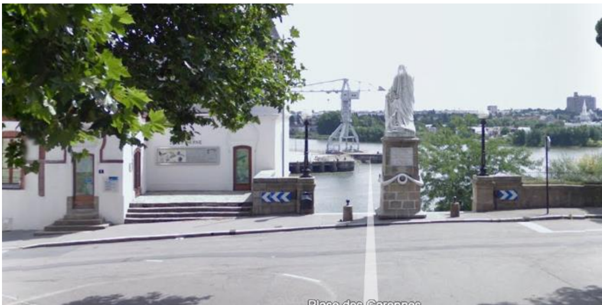
Figure 20-vue Place des Garennes, noter les proportions de la grue grise.
