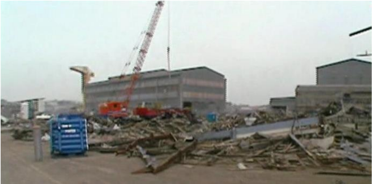
Figure 52-Le démontage des entreprises et ateliers
