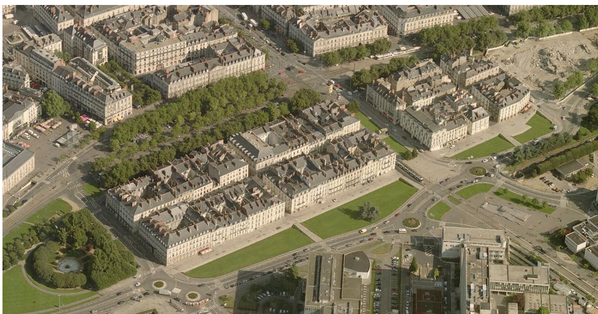
Figure 25-Ile Feydeau, le vaisseau de pierre sur son onde végétale.
