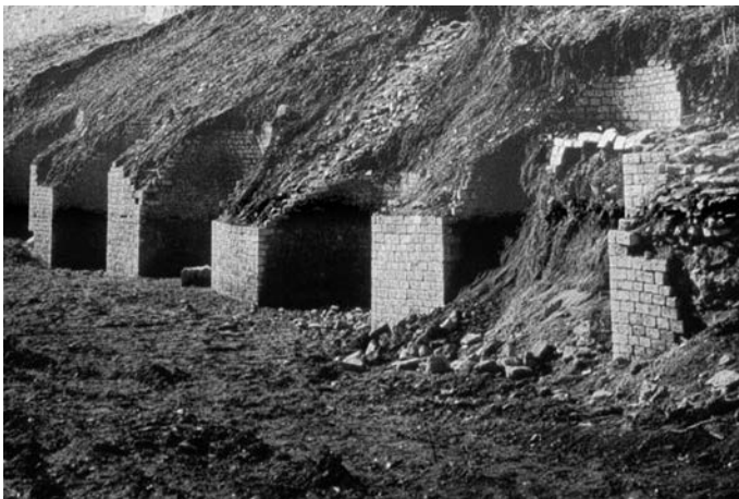
Fig. 4 - Contreforts de Sous-Bie, vue générale (cliché : Archives de la ville de Langres) et détail (cliché : S. Février).
