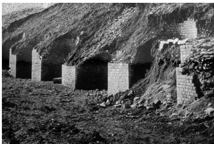
Fig. 4 - Contreforts de Sous-Bie, vue générale (cliché : Archives de la ville de Langres) et détail (cliché : S. Février).
