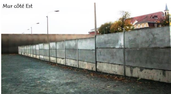
Mur côté Est
