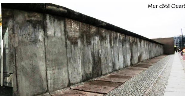
Mur côté Ouest
