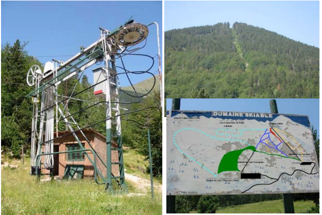
Figure 103. Anciennes installations de ski des Conques (aujourd'hui démontées), © Syndicat mixte Canigó grand Site
