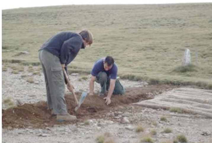
Figure 113. Révégétalisation sur le Pla Guillem en 1997, © SMCGS
