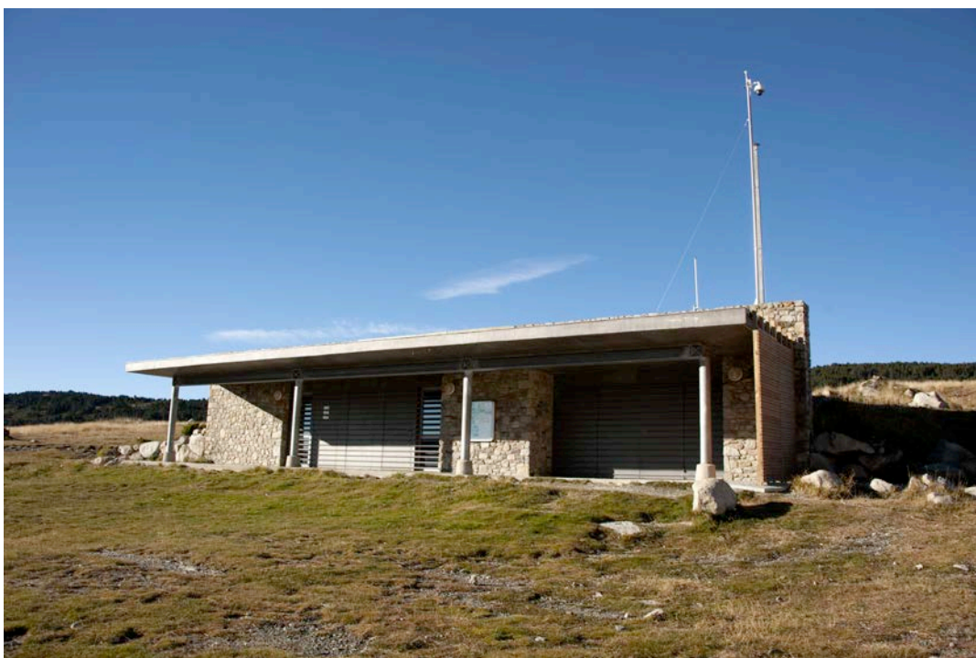
Figure 78. Bâtiment d'accueil du Conseil départemental, fermé d'octobre à juin, cliché Vincent Vlès, 2015.
