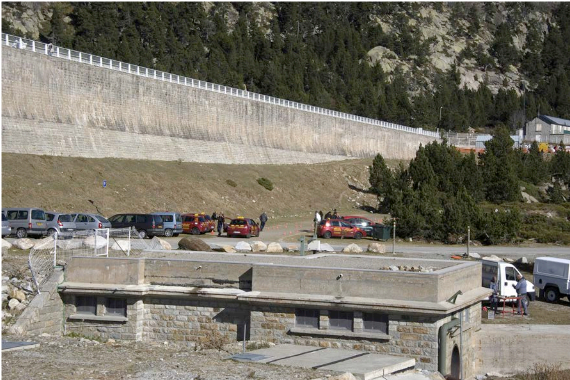
Figure 80. Des usages incongrus : ici gymkhana d'apprentissage au pilotage organisé par une auto-école sur le parking ouvert au public, en pied de digue, à 2 000 m d'altitude, cliché Vincent Vlès, 29 octobre 2011.
