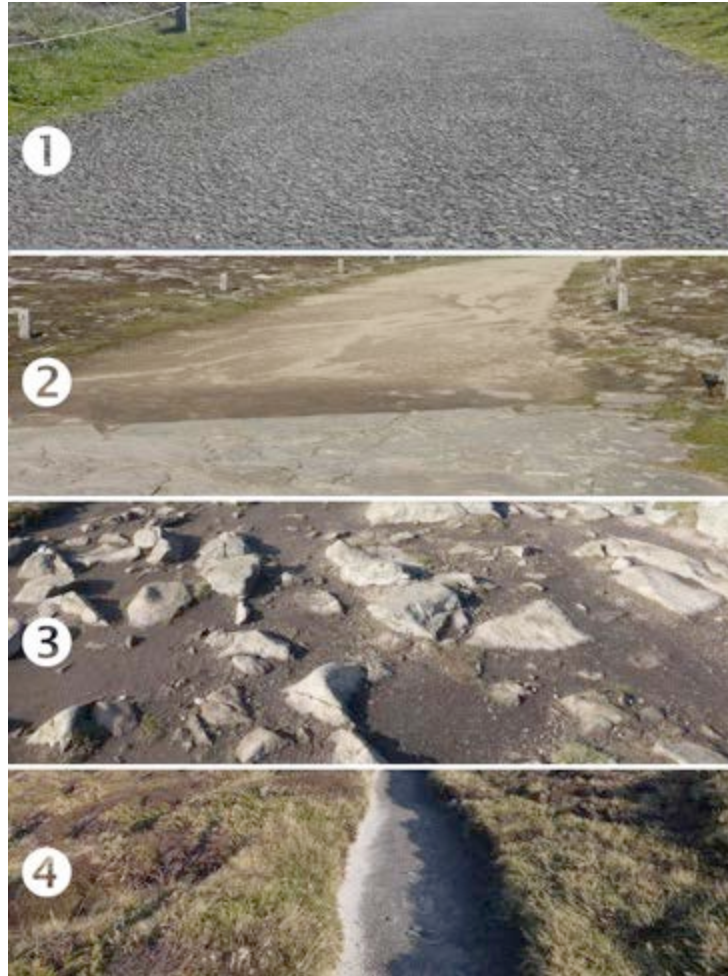
Figure 139. Les revêtements du sentier de cheminement de la Pointe du Raz.
