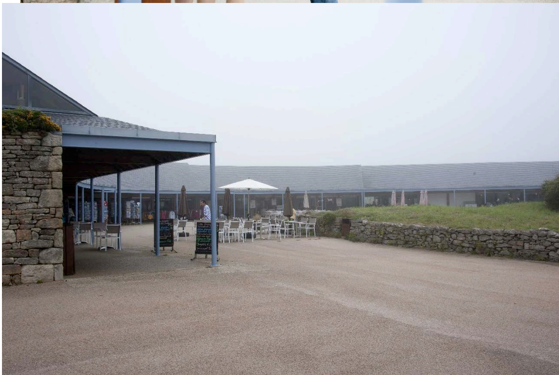
Figure 136-bis. Vue de la cité commerciale créée dans le cadre de l'opération « Grand Site » à la Pointe du Raz, cliché V. Vlès, 21/06/2015
