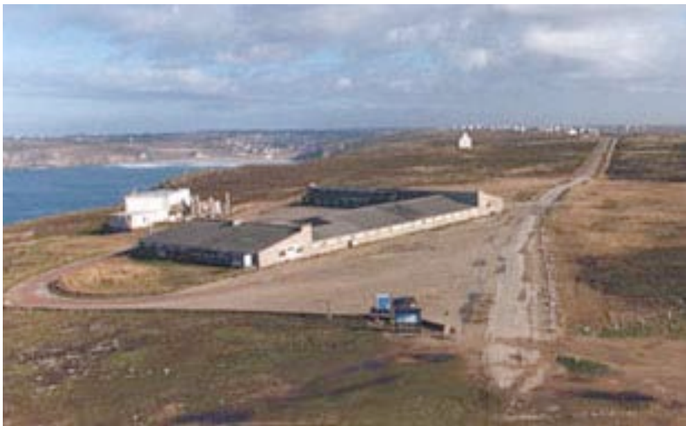
Figure 126. Cité commerciale et parking après les travaux de 1962, source : Commune de Plogoff, site web de la commune, consulté le 01.11.2015, URL : http://www.plogoff-pointeduraz.com/patrimoine/histoire
