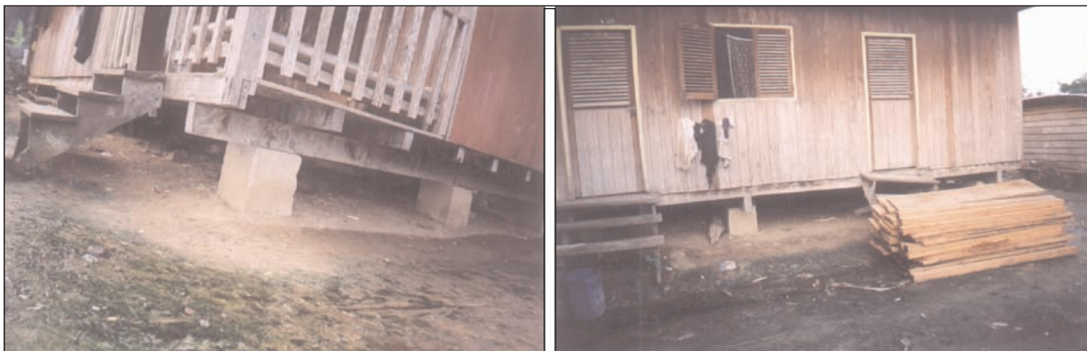
Photos 3-4 : Dans certains villages, les maisons des employés de la plantation sont construites sur pilotis dans des marécages asséchés. L'espace entre le sol et le plancher des maisons, en planches, constitue alors un gîte de repos et une importante cache pour les anophèles.
