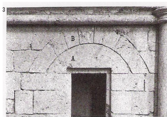
Fig.2 – Arc de décharge (A-Linteau ; B-Arc de décharge)
