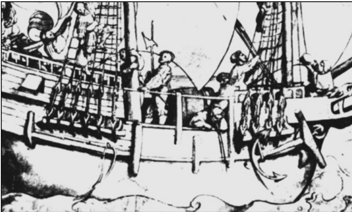
Figure 54 - Haubans mis en tension à l'aide de caps de moutons 23
