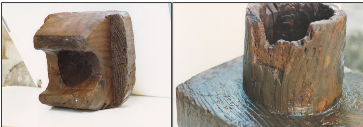
Figure 4 – Détails du pied de pompe
