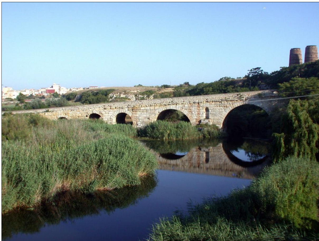
Figura 5. Porto Torres. Il ponte romano localizzato tra l'area industriale ed il centro urbano. Oggetto di recenti interventi di restauro
